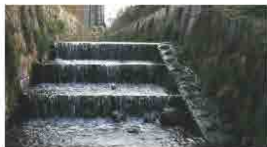
図5-4 設置されたスロープ付きの落差工
