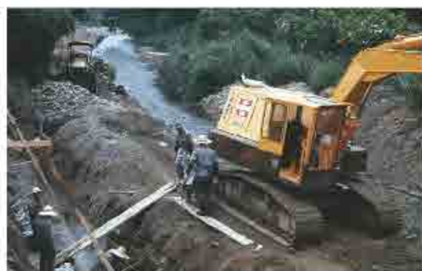
図5-1 GSチームが駆け付けた工事現場。1973年6月5日撮影
